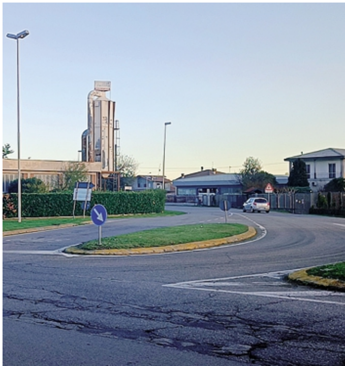
L'area dove verrà realizzata la rotatoria a Castel Rozzone
